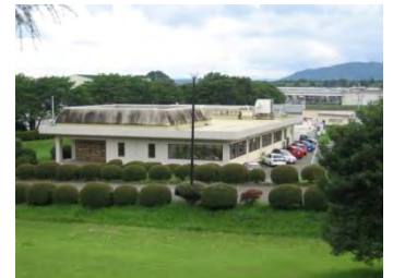
写真 2-8-4 生物工学実験棟
