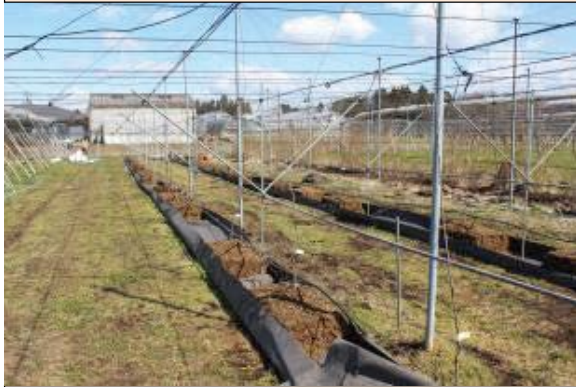
盛土サイドの遮根シートを引き上げる
