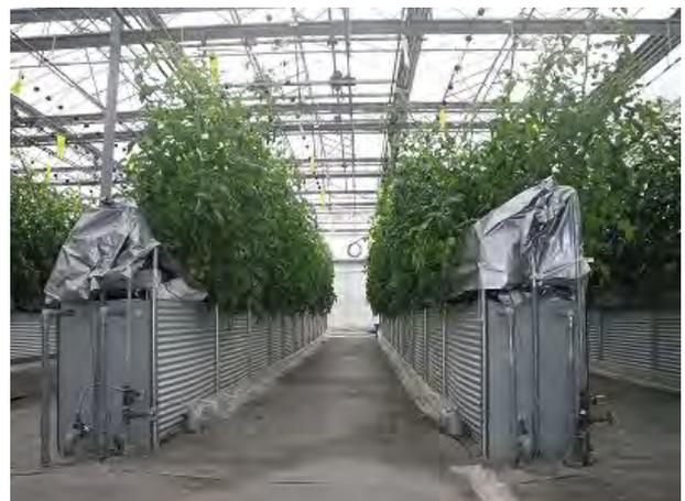
写真 2-3-7 蓄熱式栽培環境制御システム
