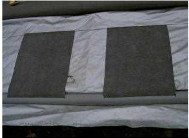
写真7 給水マットを給水管に挿入
