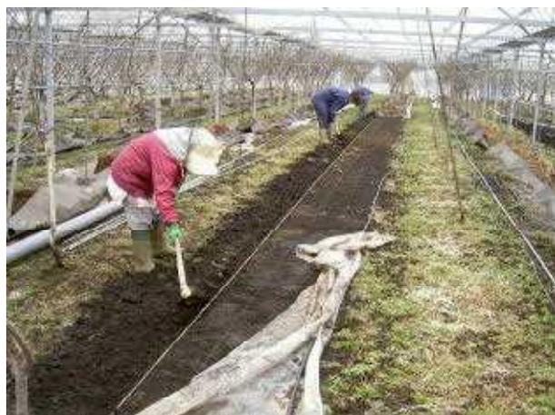
写真4 給水管を埋める溝掘り
