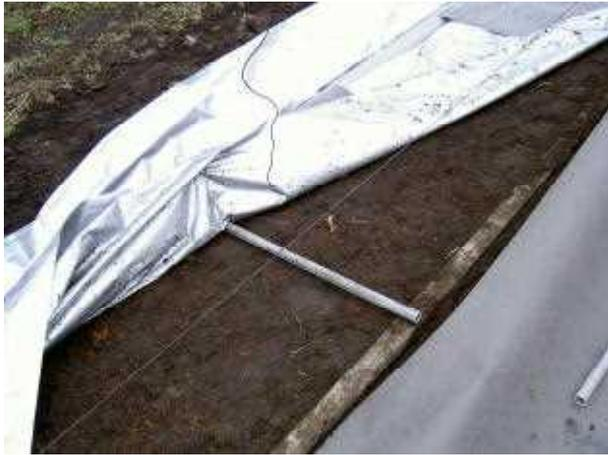
写真6 給水管の反対側を高くし傾斜をつける
