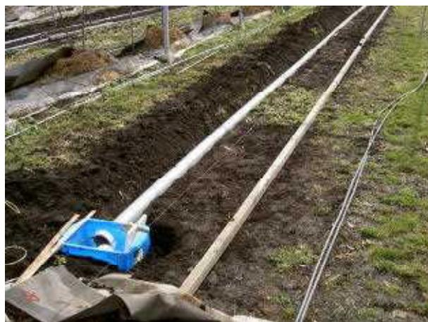
写真5 給水槽、給水管の設置
