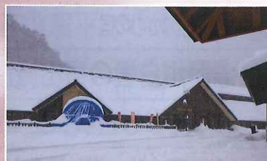
山の銘木で造られた水の郷観光センター
